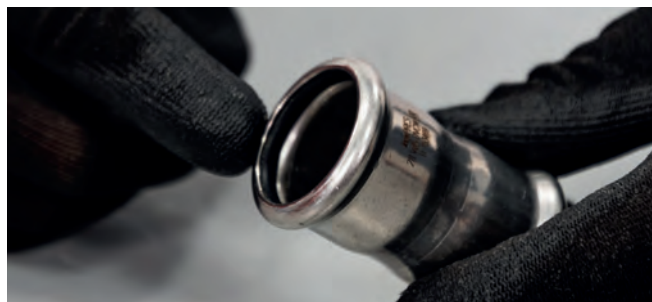
Bilde 35 – Kontroll av tetningsring
